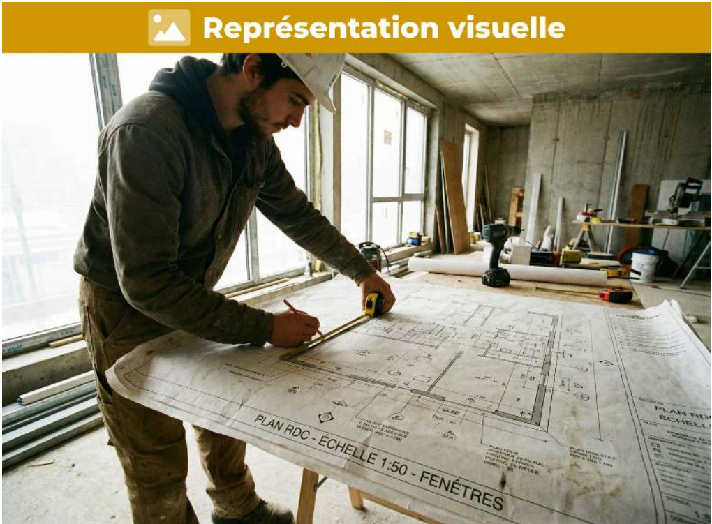
La fenêtre mesurée à 4 cm sur le plan correspond à 200 cm réel selon l'échelle 1:50
